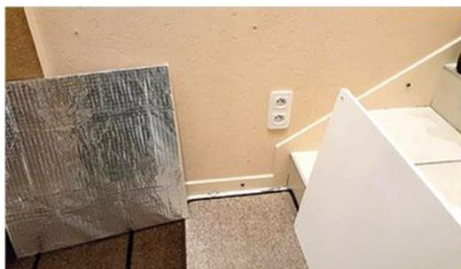
«Fabriquer un panneau isolant et réfléchissant pour radiateur! Economie d'énergie!», tutorial de la chaîne Youtube Solutions & Savoir-Faire. Film + plaque d'isolant.
