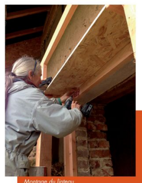
Montage du linteau
