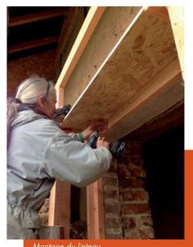
Montage du linteau
