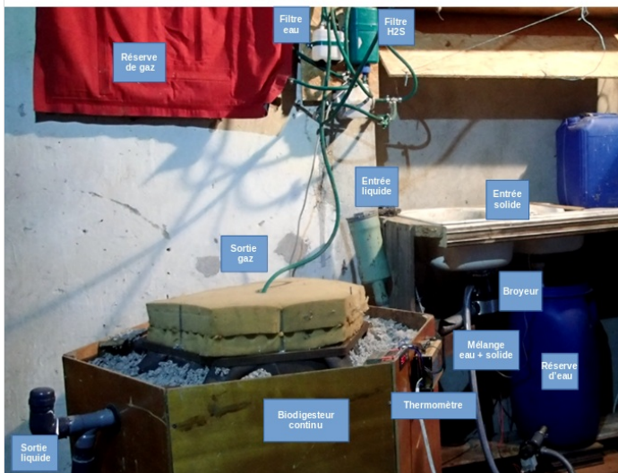
Le biodigesteur continu
