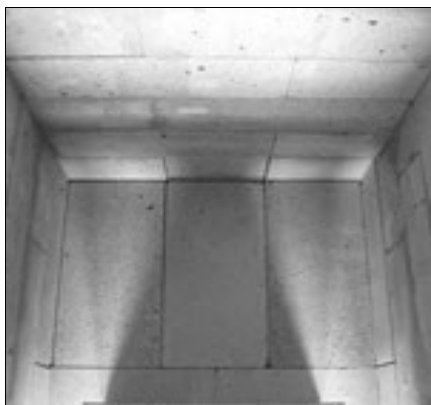
Hérisson de poêle à granulés et accès ramonage par le fond du foyer en cours de démontage
