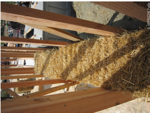
Mur en paille pour isoler
