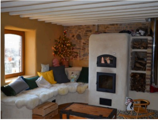
Poêle à bois qui chauffe une banquette
