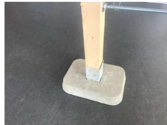
Détails du montage : tiges filetées et écrous fixées dans poteau en bois. Pied stabilisé en béton.
