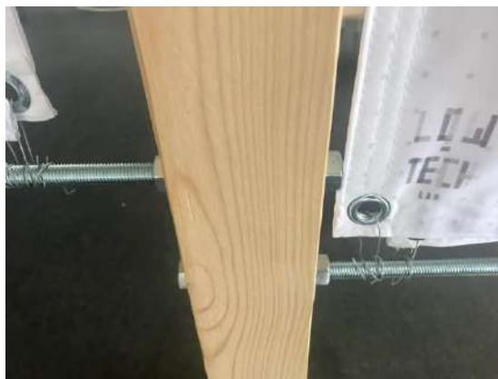
Détails du montage : tiges filetées et écrous fixées dans poteau en bois. Pied stabilisé en béton.
